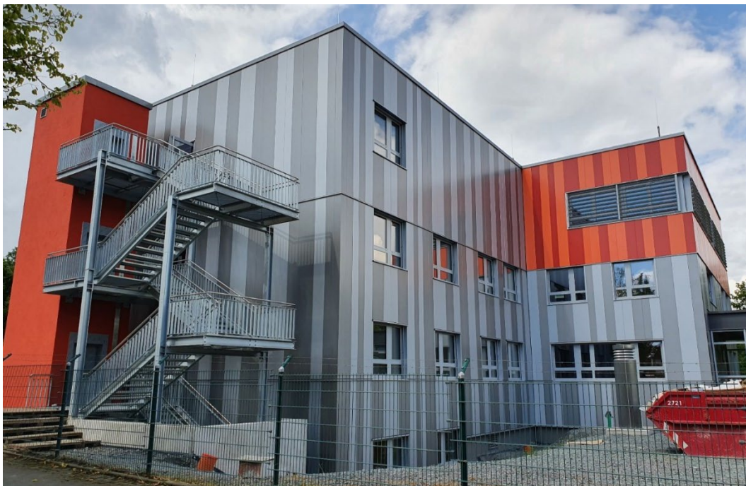
Abbildung 20: Sanierung Steinkaute Stand August 2021
