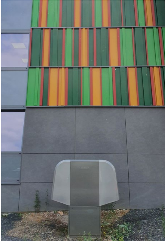
Abbildung 11: Wärmepumpe Homburger Str.
