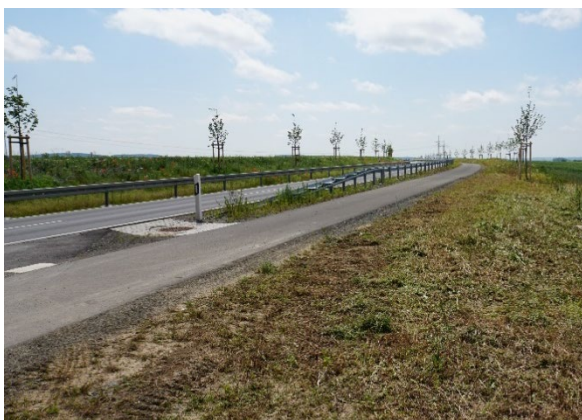
Abbildung 32: Radwegausbau an der K11
