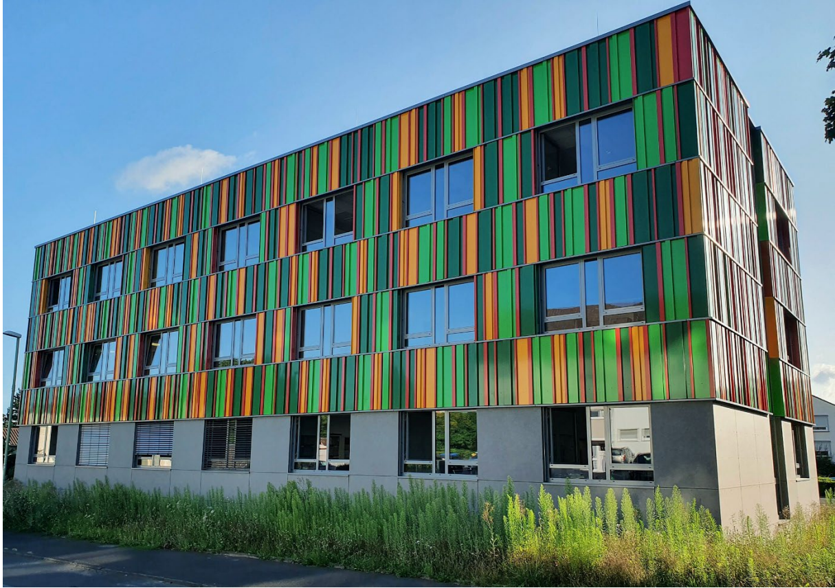
Abbildung 22: Anbau Homburger Straße „Haus der Umwelt“
