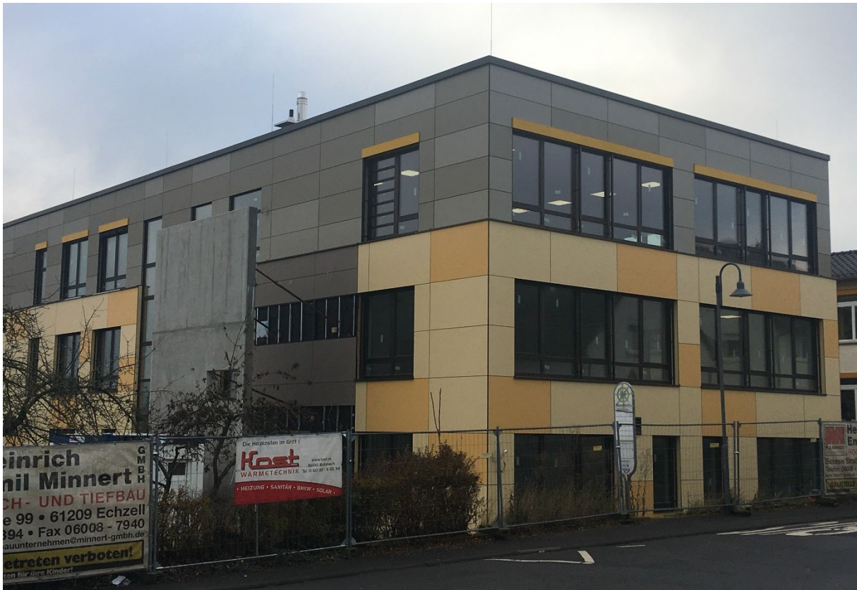
Abbildung 23: Neubau an der Rosendorfschule in Bad Nauheim/Steinfurth
